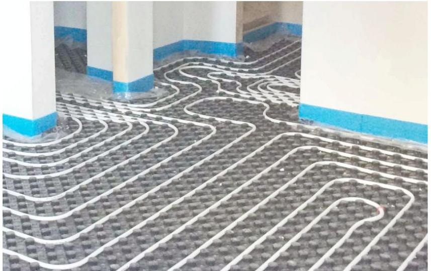
L'impianto è costituito da tubi, che svolgono le dinamiche di termoregolazione, posti sotto il pavimento a una certa profondità dalla superficie calpestabile, profondità che dipende principalmente da fattori come l'altezza del soffitto nel locale e la larghezza dello stesso.
